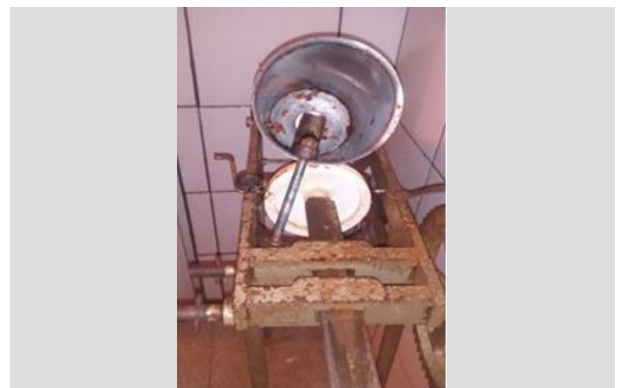
Figura 2 - equipamento enferrujado e sem higienização
